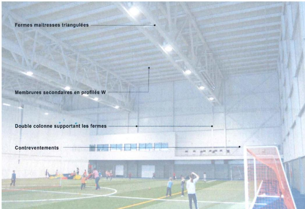
Fig. 33 – Vue d’ensemble du Complexe Victoriaville avec comparaison des éléments de structure similaires (Infographie ABCP)
