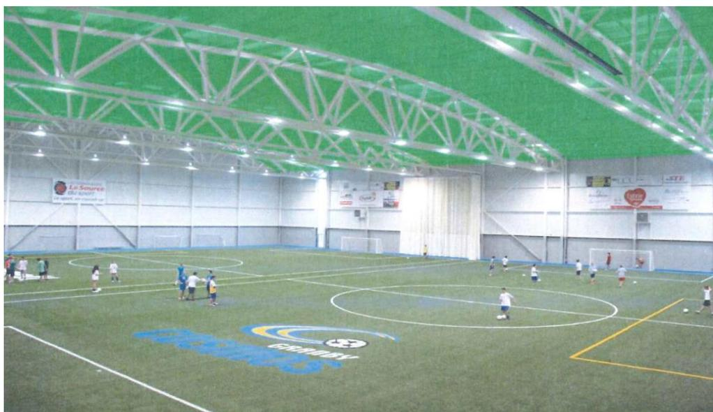
Fig. 22 – Membrures secondaires fixées aux membrures en porte-à-faux et pontage de toiture (Infographie ABCP sur photographie représentative du Complexe Artopex)
